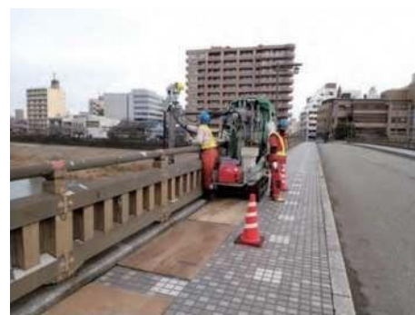
橋梁点検支援ロボットによる点検
