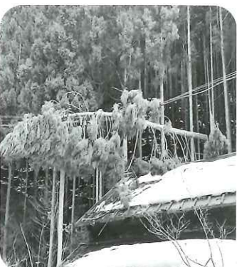
道路わきの通信線への倒木の様子
