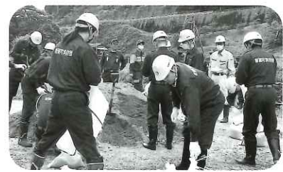
水防工法の基本土のう作り
