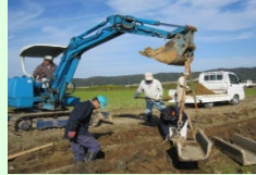
コンクリート水路の更新
