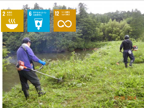
ため池堤体の草刈り
