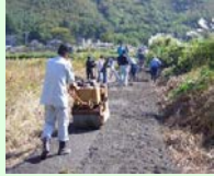
未舗装農道の舗装
