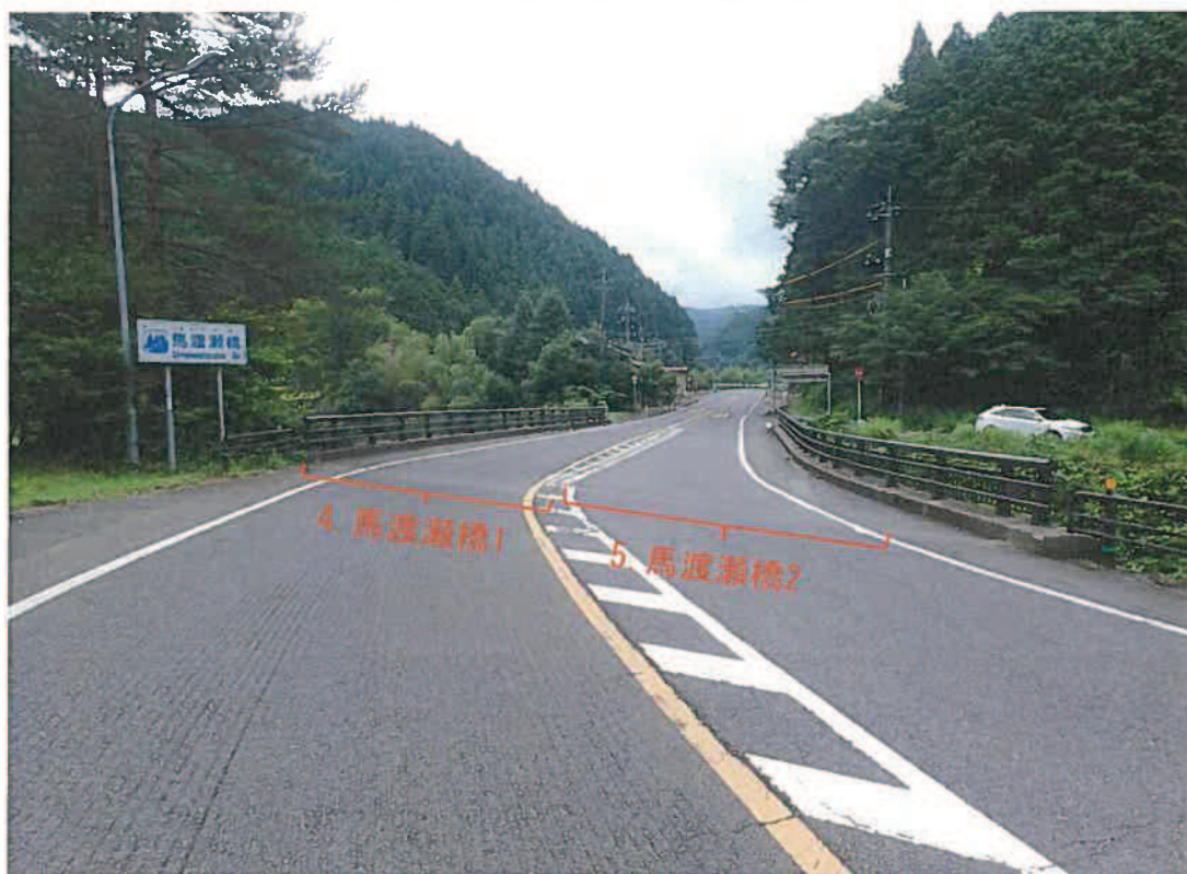
馬渡瀬橋 起点側
