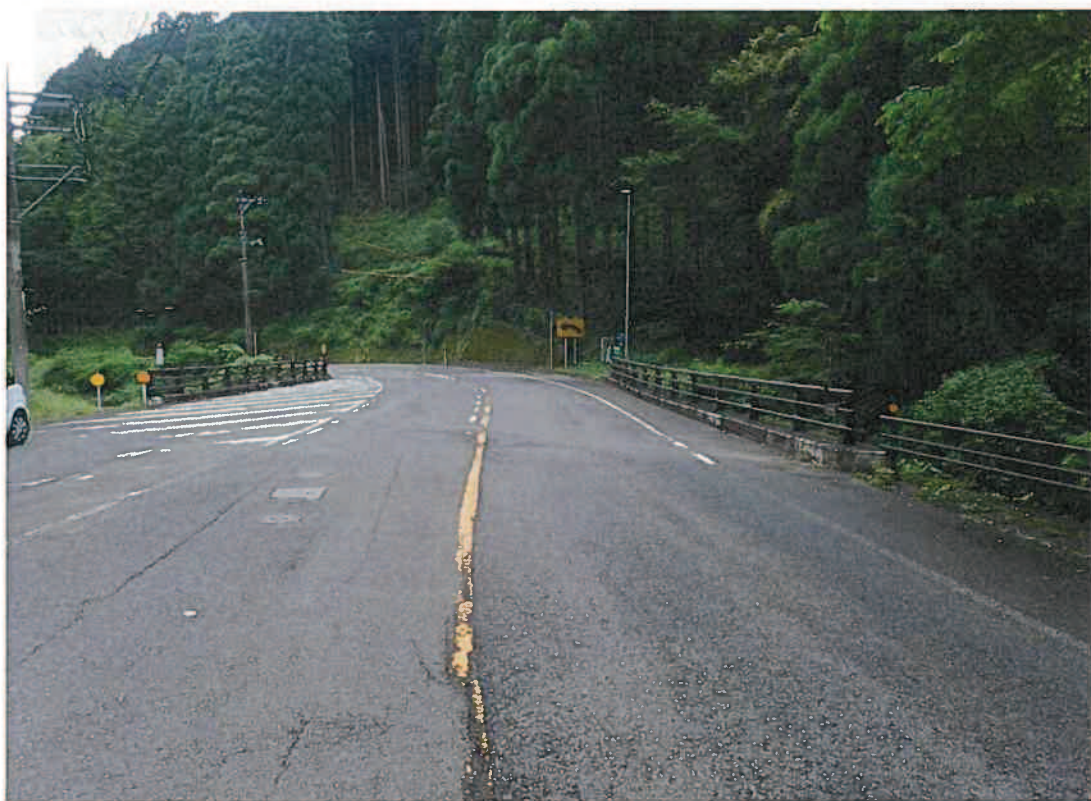
富田橋 起点側
