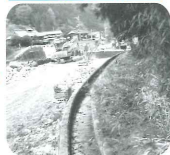
修繕後の状況
