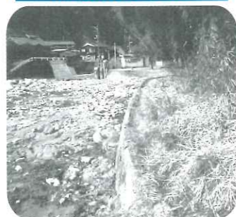
修繕前の状況
