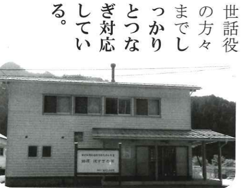
山形地区にあるお試し住宅(郷原地内)
