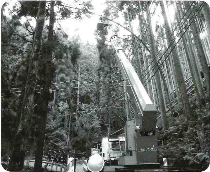
県道智頭用瀬線の危険木伐採作業
