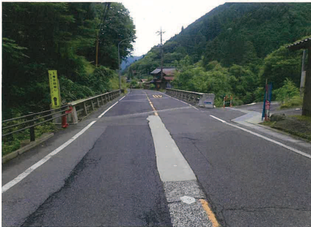
樽見橋 起点側
