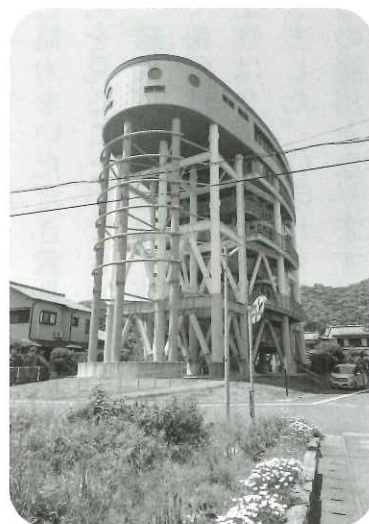
高さ22mで230人を収容できる津波避難タワー
