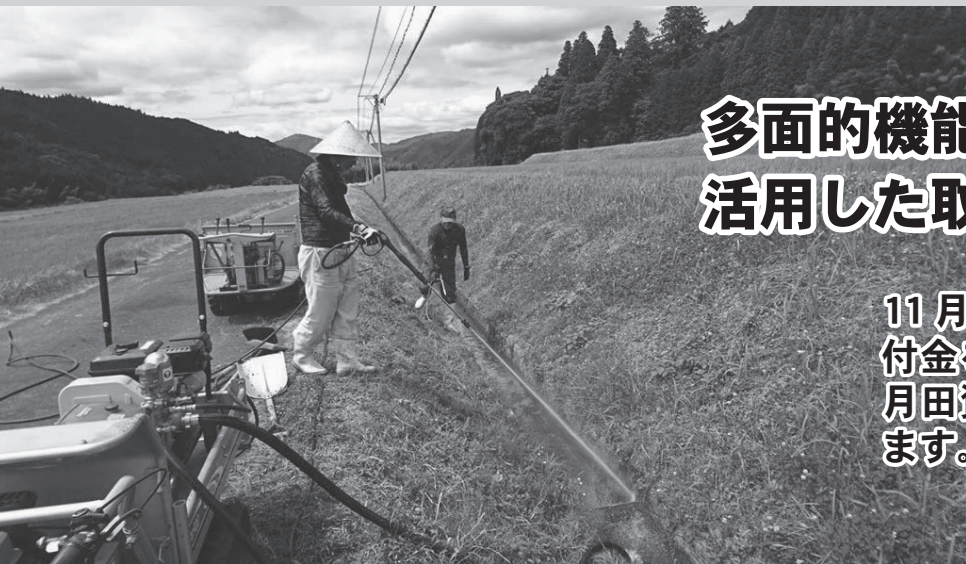
◀高圧洗浄機で目地補修の下処理
