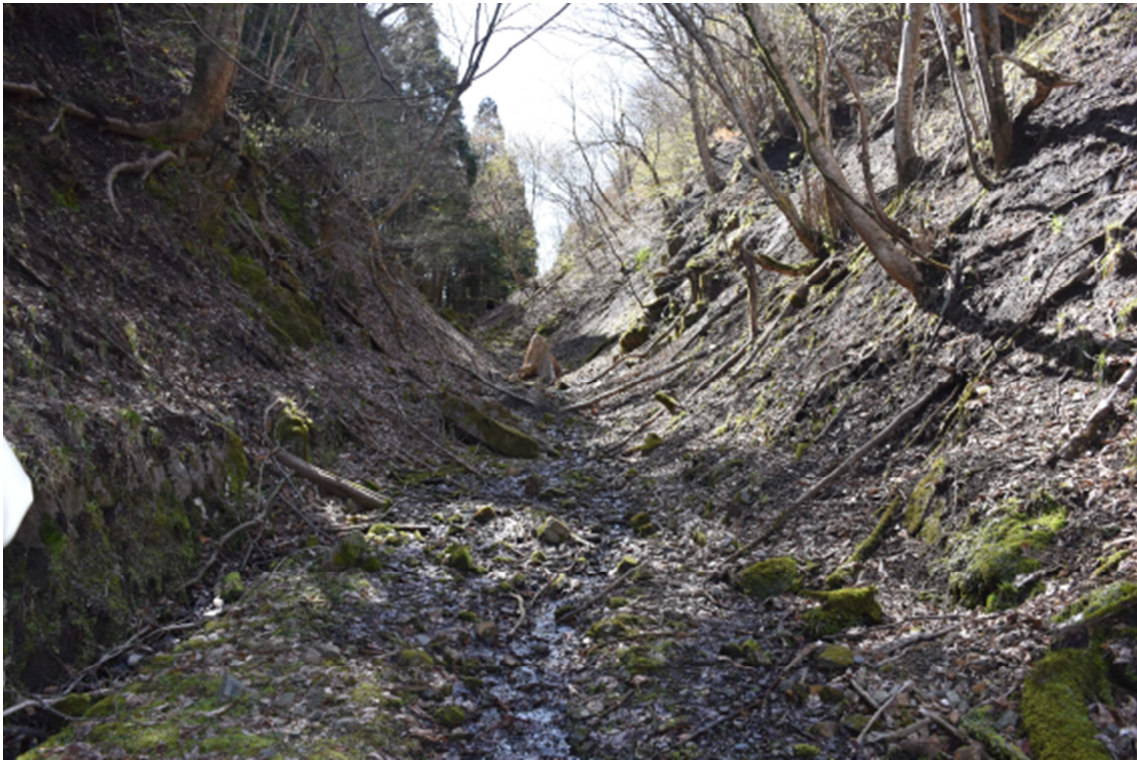
大雨により法面が崩落し危険な状態（峠上部）
