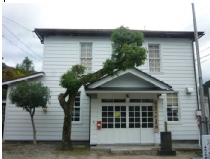
整備後（外壁修繕）
