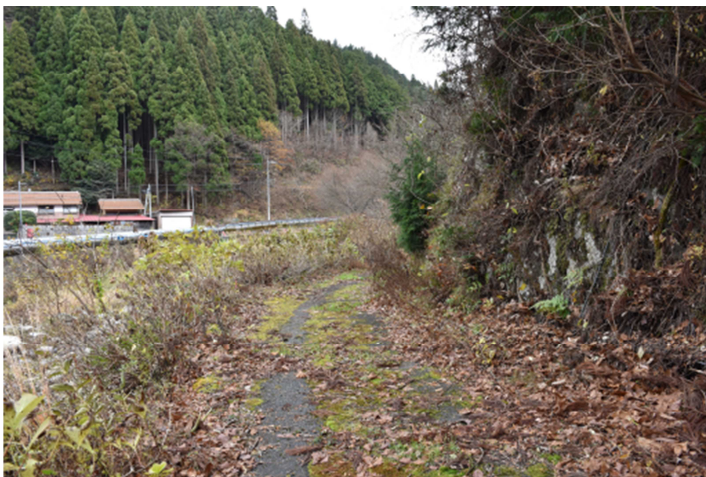
沖ノ山森林鉄道軌道跡の一部
