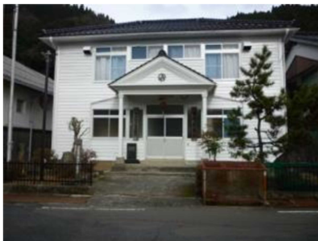
整備後（外壁修繕）
