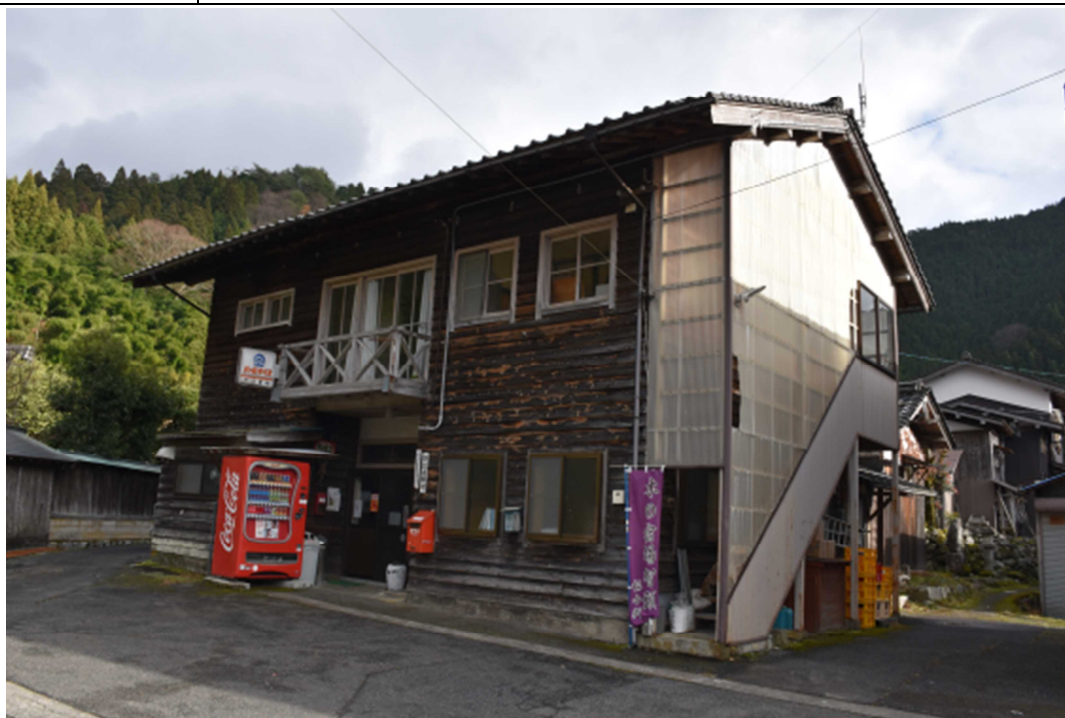
芦津部落事務所の現況
