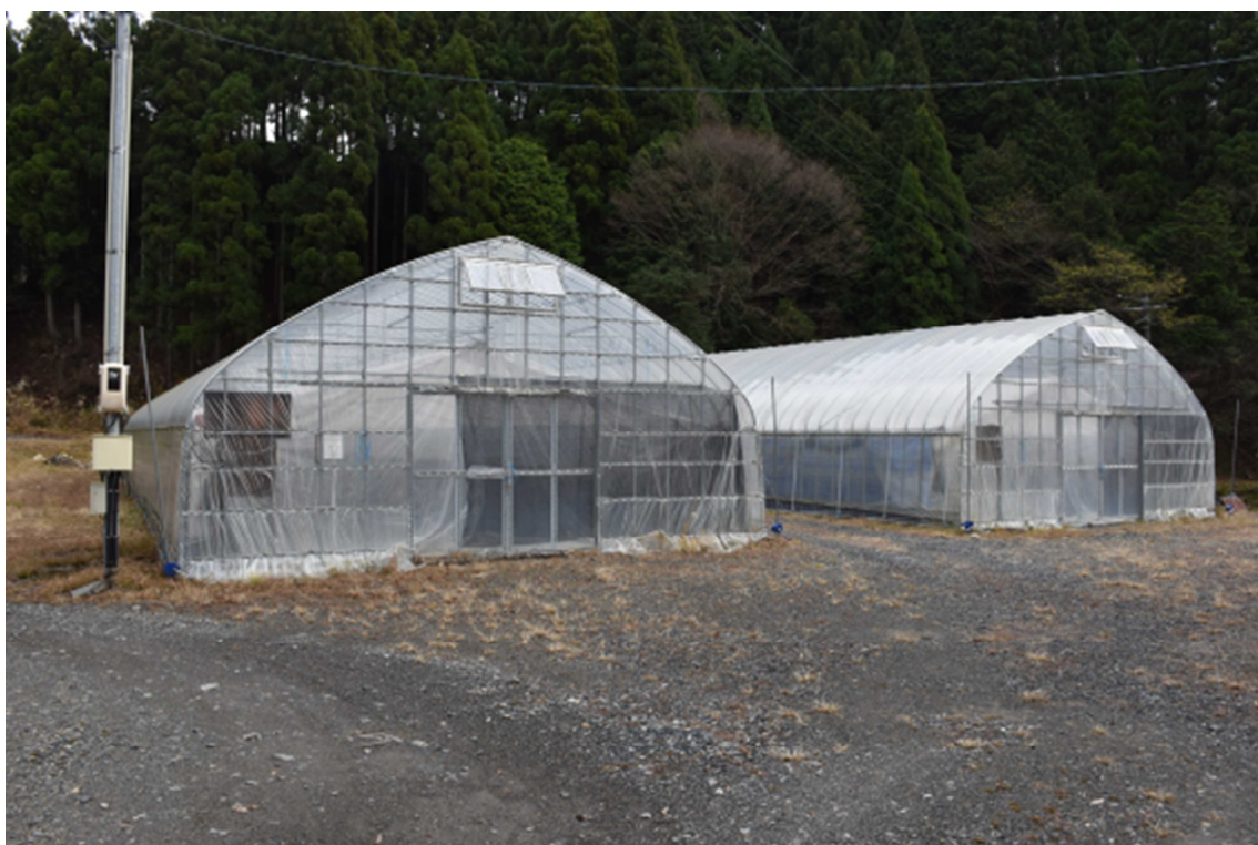
沖ノ山国有林芦津貯木場の現況
