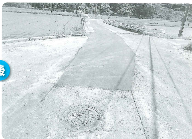
修繕後の状況
