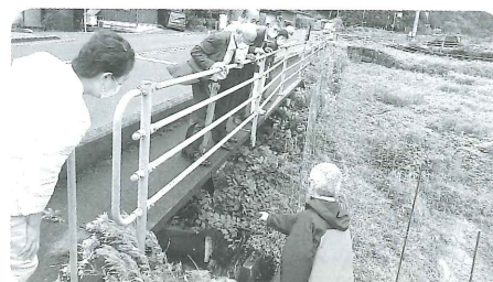
中島地区内の現場
