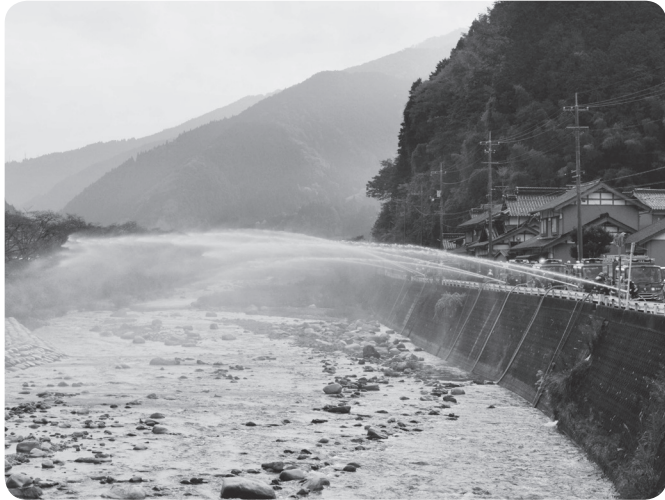
一斉放水の様子
