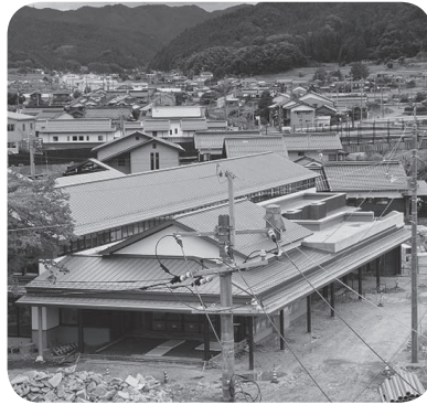
9月2日（水）建設現場の様子
