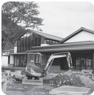
外構工事の様子
