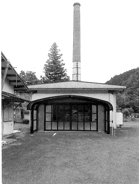
昭和40年に設置され53年が経過する町営火葬場
