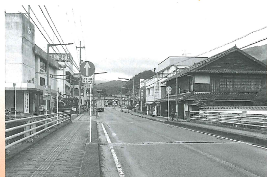
役場前の智頭橋は、7月豪雨で土師川が増水し、越流する恐れがあった。
