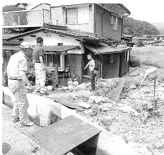
土石の流出で被害を受けた民家(上市場地内)
