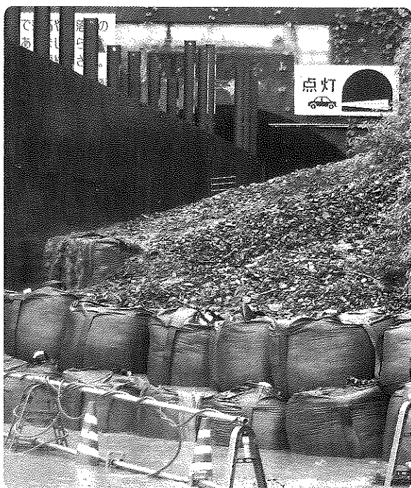
土砂流出状況(智頭トンネルの智頭側・7月12日)
