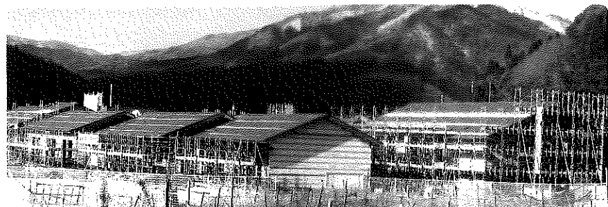
保育園建設状況(12月下旬)
