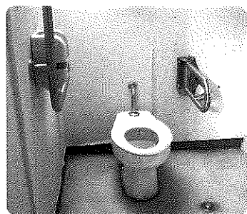
総合センター1階の障がい者用トイレ
