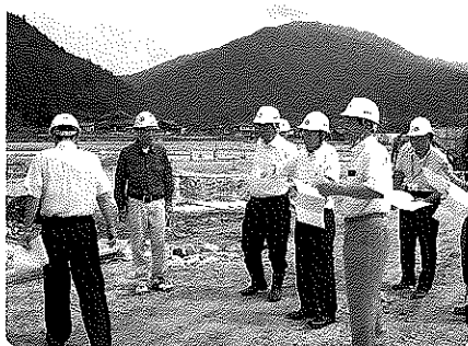
保育園建設現場を視察
