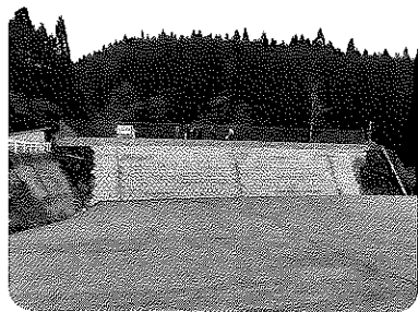
クリーンセンター跡地整地後
