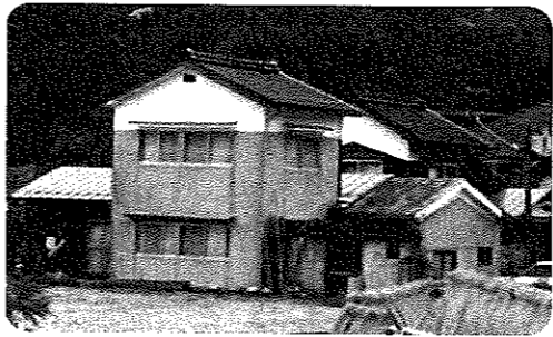
老朽化が進む町営住宅(久志谷地区)
